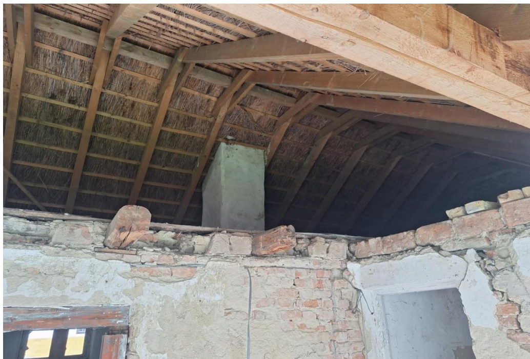
A lakóház feletti tetőszerkezet.
