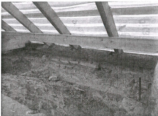
Vasbeton koszorú kivitelezése
