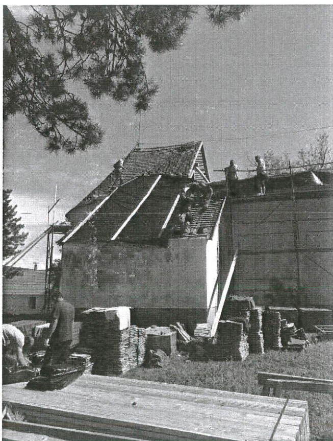
A tetőszerkezet bontása
