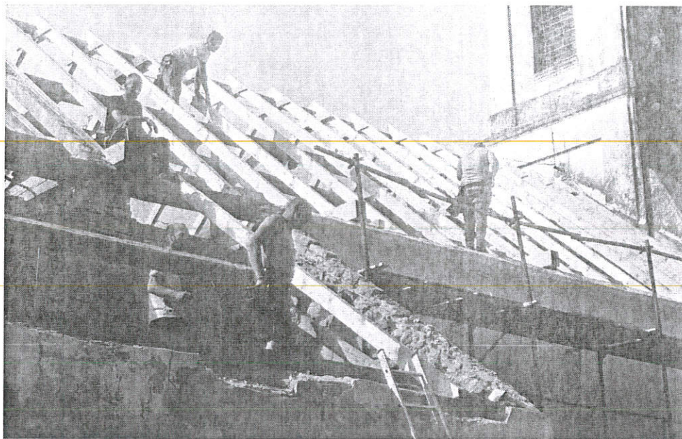
Új tetőszerkezet építése
