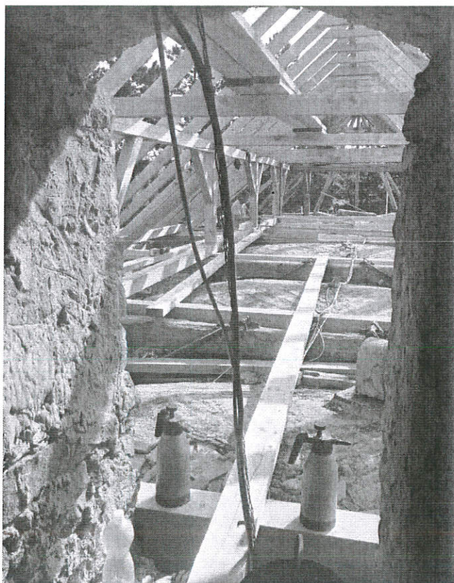
Az új tetőszerkezet, rovarölő szerrel kezelve
