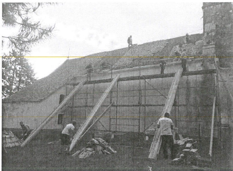
A tetőszerkezet bontása
