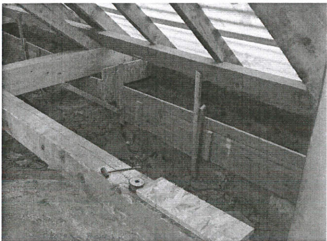
Vasbeton koszorú kivitelezése
