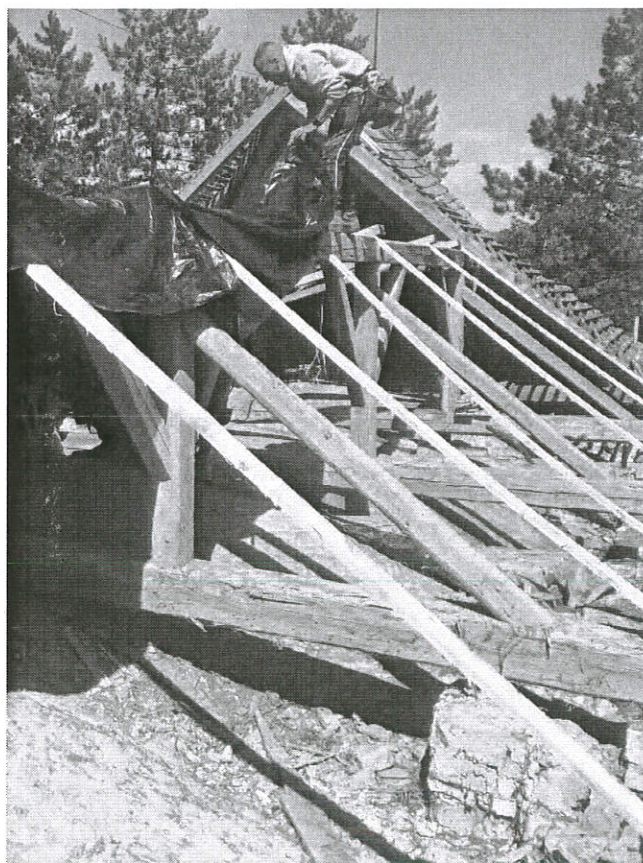
A tetőszerkezet bontása
