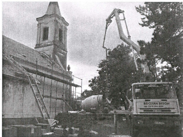
Vasbeton koszorú kivitelezése
